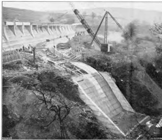
FIG. 61. SPILLWAY CHANNEL; KES DAM.
